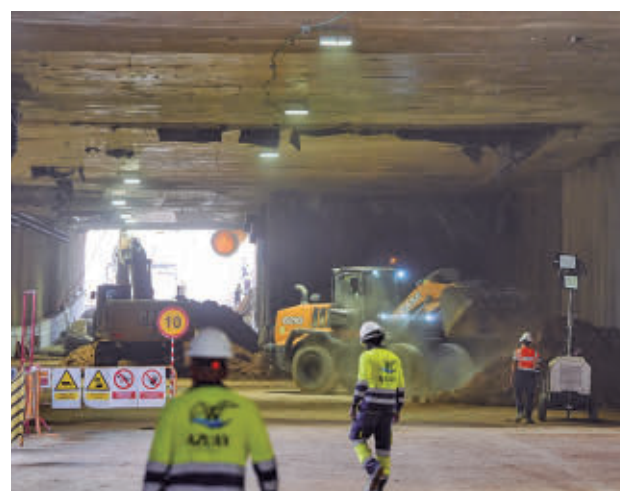
Los trabajos en el interior del paso subterráneo
