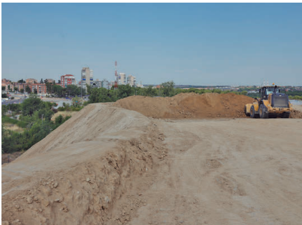
Los trabajos de retirada de tierra en el entorno de la autovía
