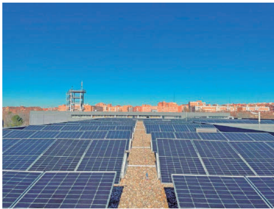
Los edificios incorporan un sistema híbrido de alta eficiencia AYUNTAMIENTO DE ALCORCÓN
