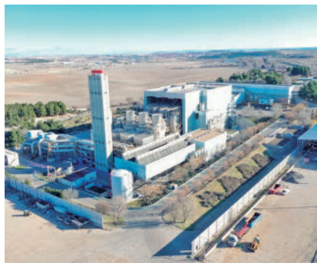
Planta de Las Lomas de Valdemingómez AYUNTAMIENTO DE MADRID
