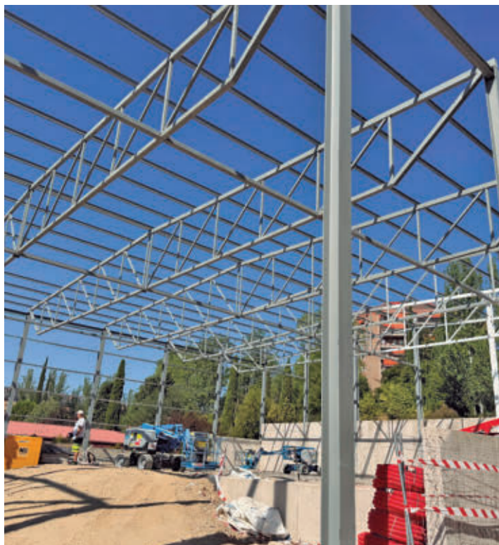
Estado del futuro pabellón de pádel indoor AYTO DE TRES CANTOS
