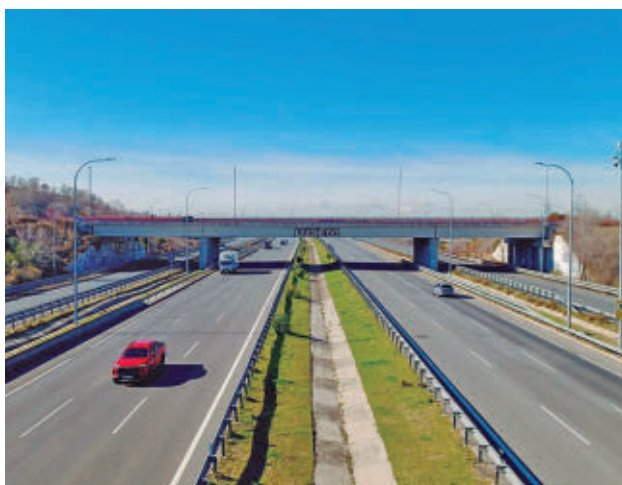
Uno de los puentes sobre la autovía M-45
