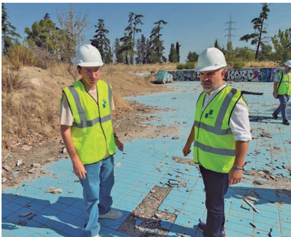
Visita a las obras de las nuevas instalaciones
