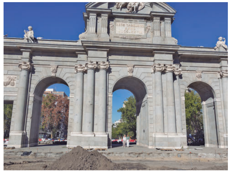
Las obras en el entorno de la Puerta de Alcalá
