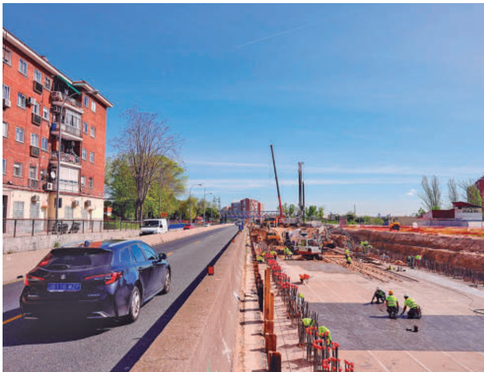
Los trabajos de soterramiento de la A-5 a su paso por el distrito de Latina
