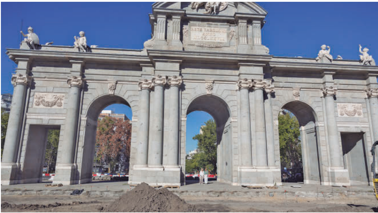
Las obras en el entorno de la Puerta de Alcalá
