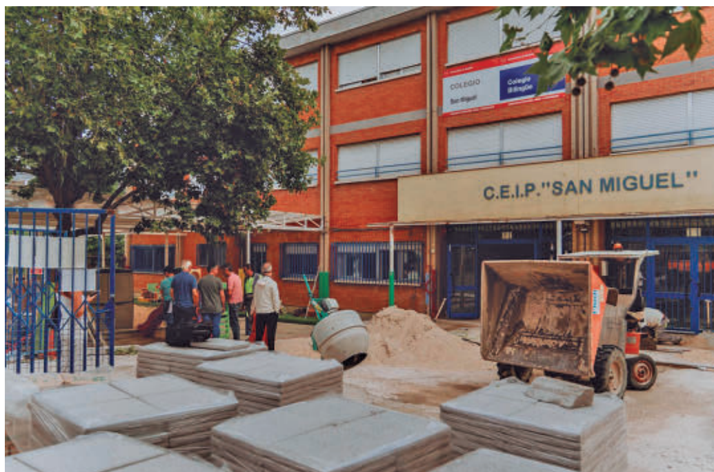
Una de las obras que se han llevado a cabo este verano
