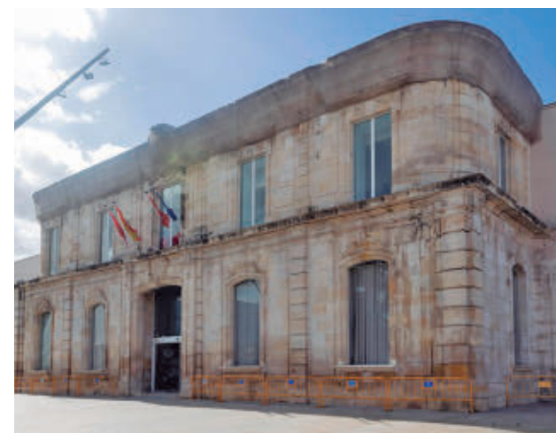
Ayuntamiento de San Fernando de Henares
