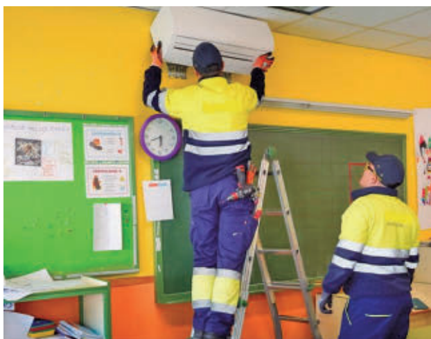
Instalación de un aparato de aire acondicionado
