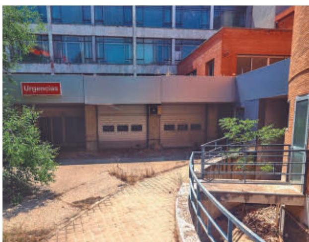
Antiguo Hospital Puerta de Hierro. E. P.
