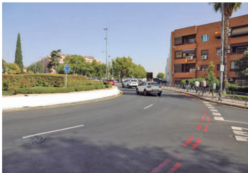
Mantenimiento ha llevado a cabo trabajos de reparación de la glorieta Isidro Parejo Risco
