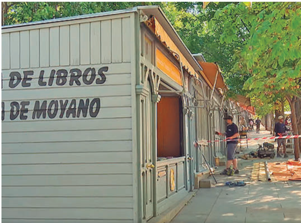
Las obras realizadas en los puestos de la feria
