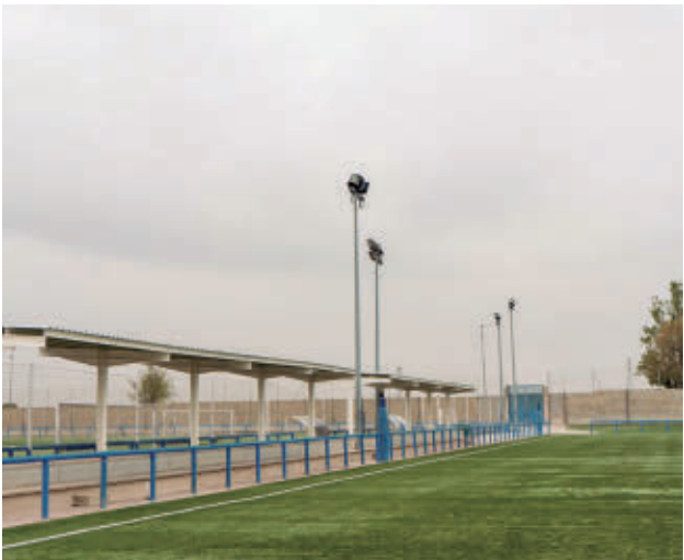
La cubierta protege ahora el graderío de las inclemencias
