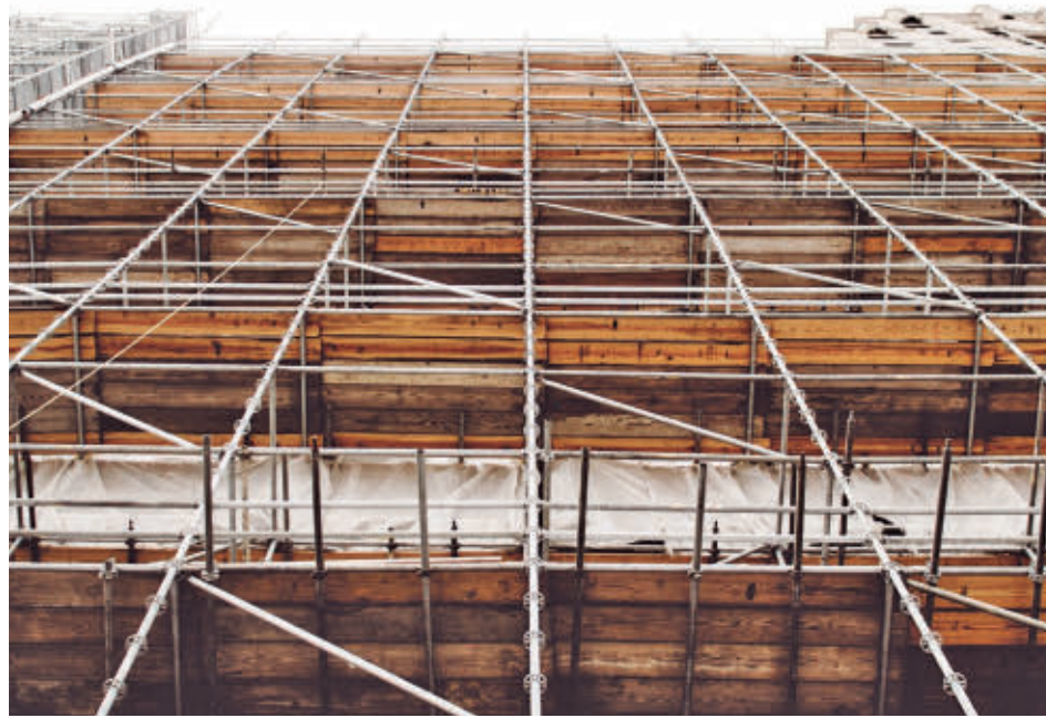
Edificio en rehabilitación en Fuenlabrada
