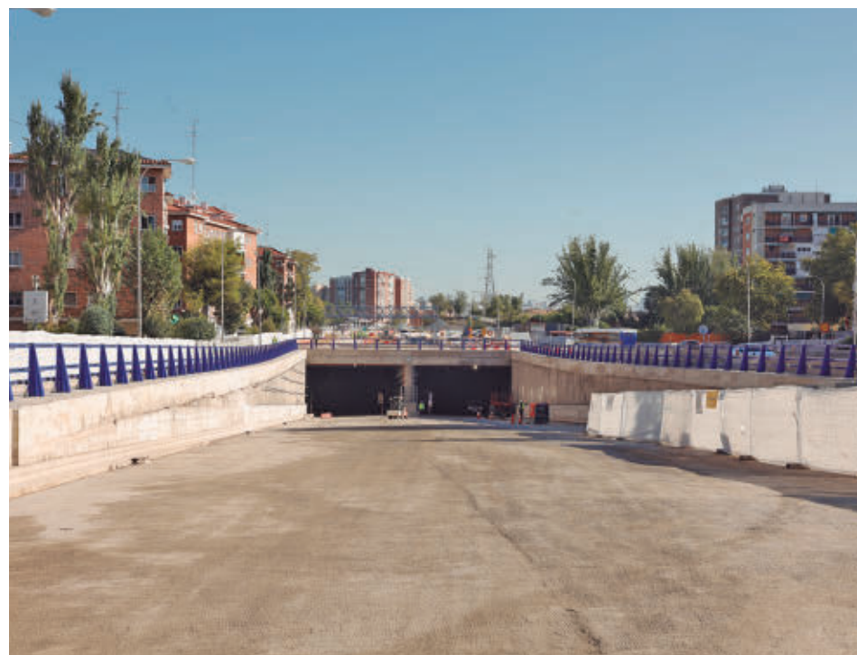
La entrada al túnel de la A-5
