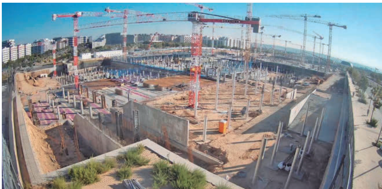
Obras en la Ciudad de la Justicia de la Comunidad de Madrid
