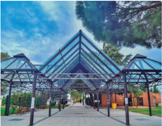
Cementerio de Torrejón de Ardoz
