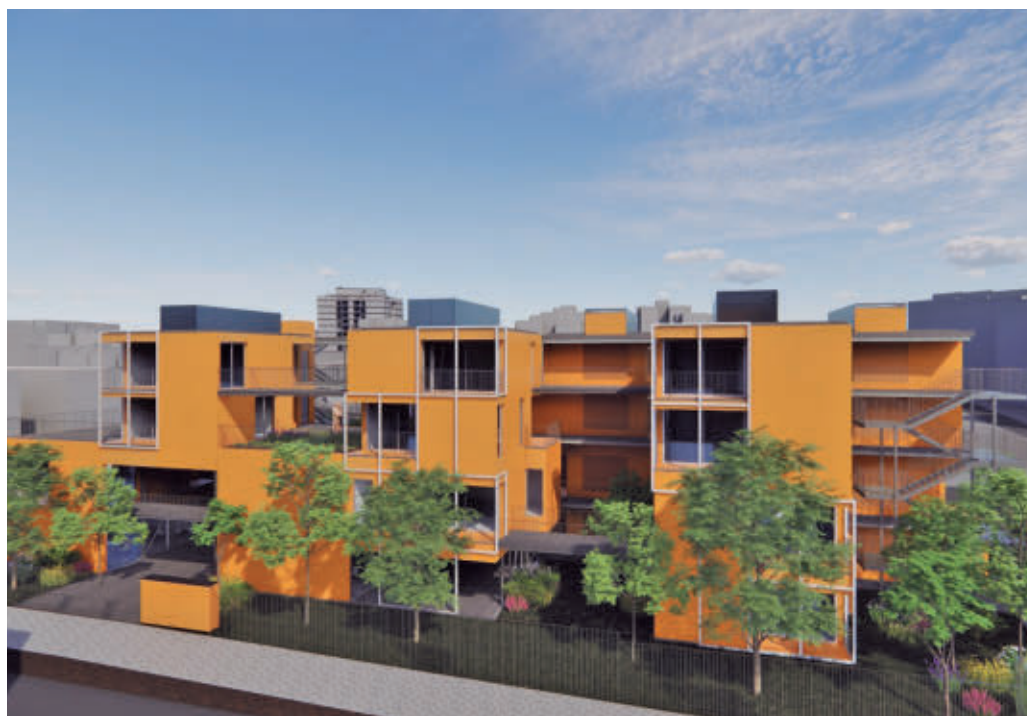
El proyecto reutilizará parte de un edificio educativo en desuso AYTO DE FUENLABRADA
